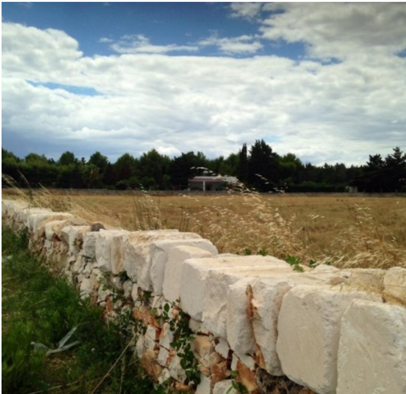
Muretti a secco
