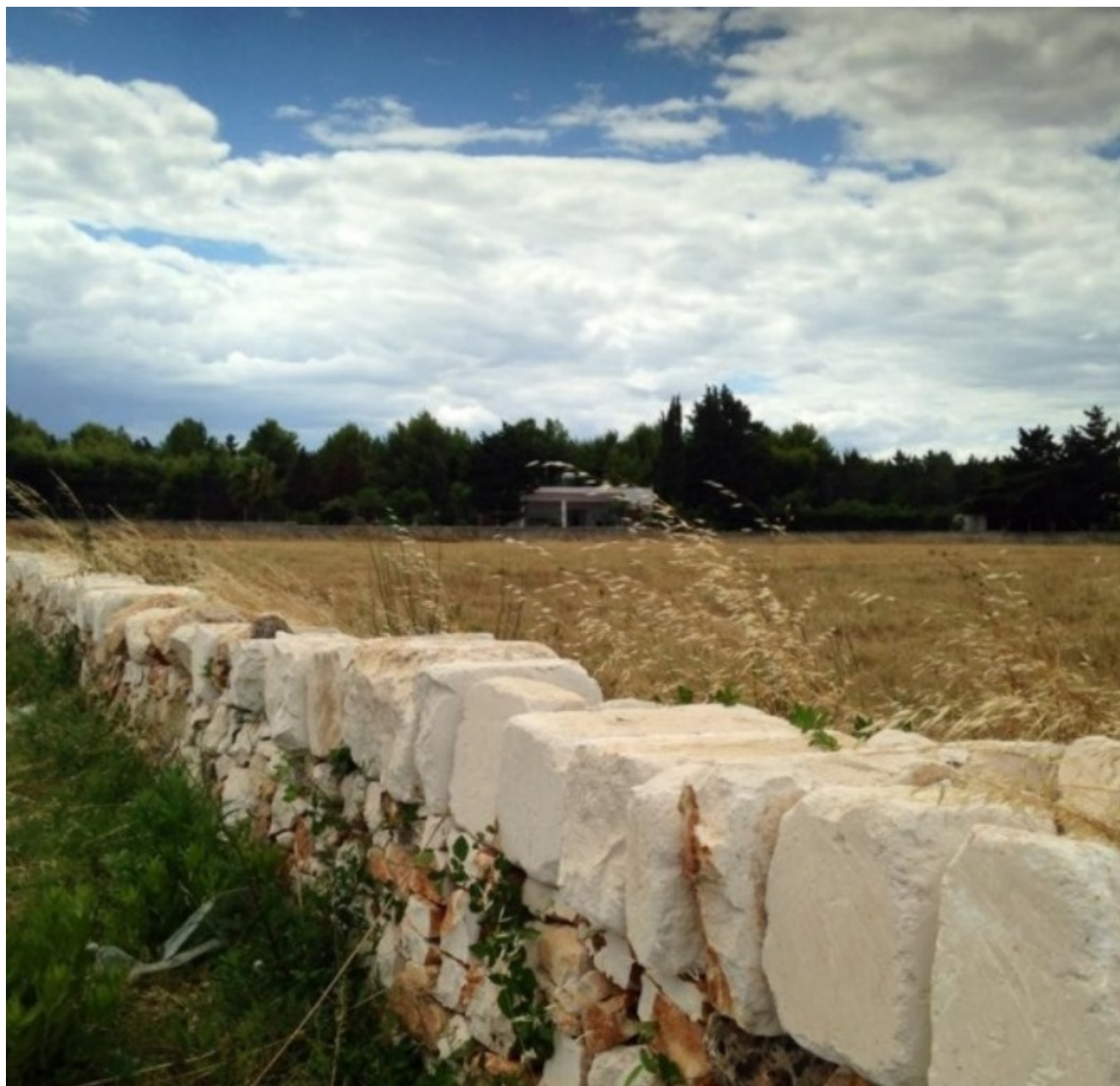
Muretti a secco
