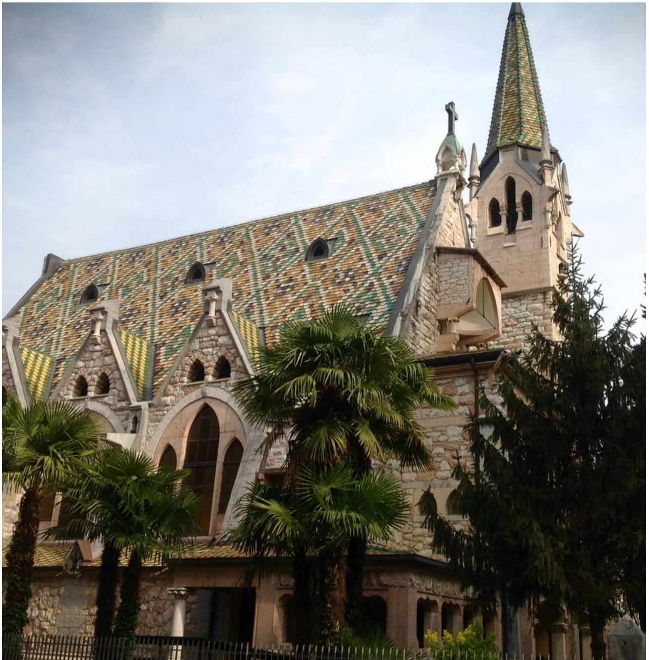
Chiesa Evangelica della Trinità – Arco
