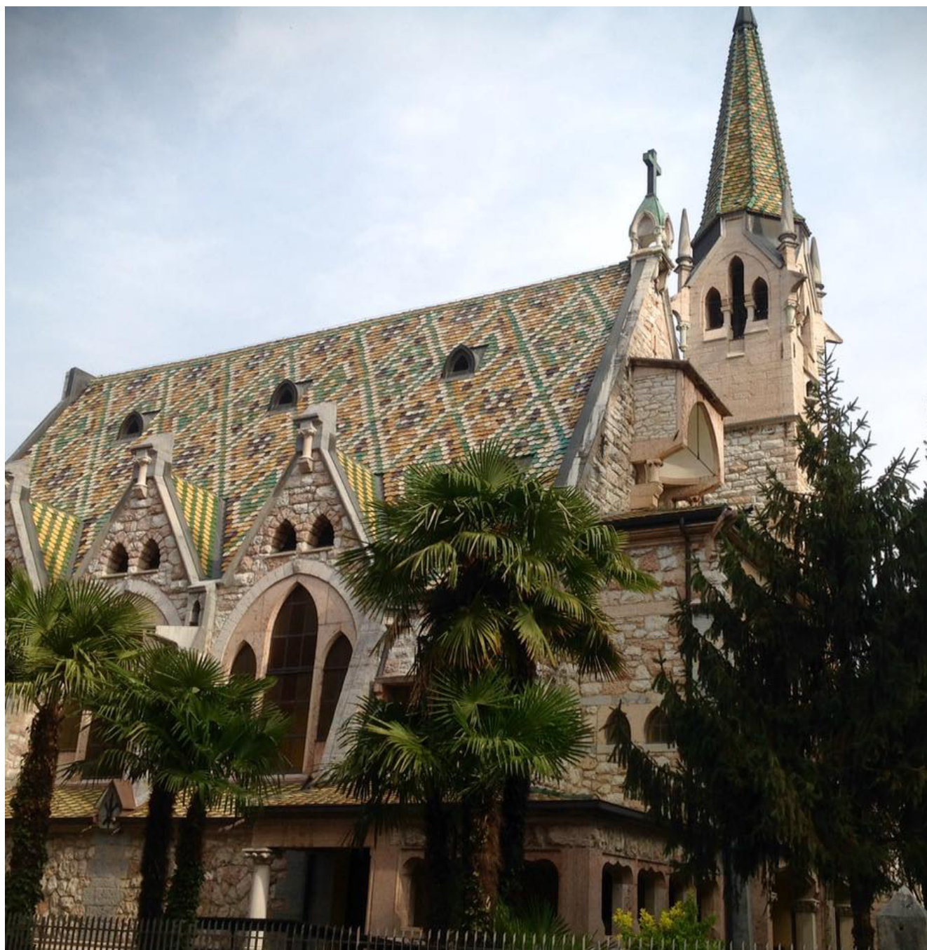
Chiesa Evangelica della Trinità – Arco
