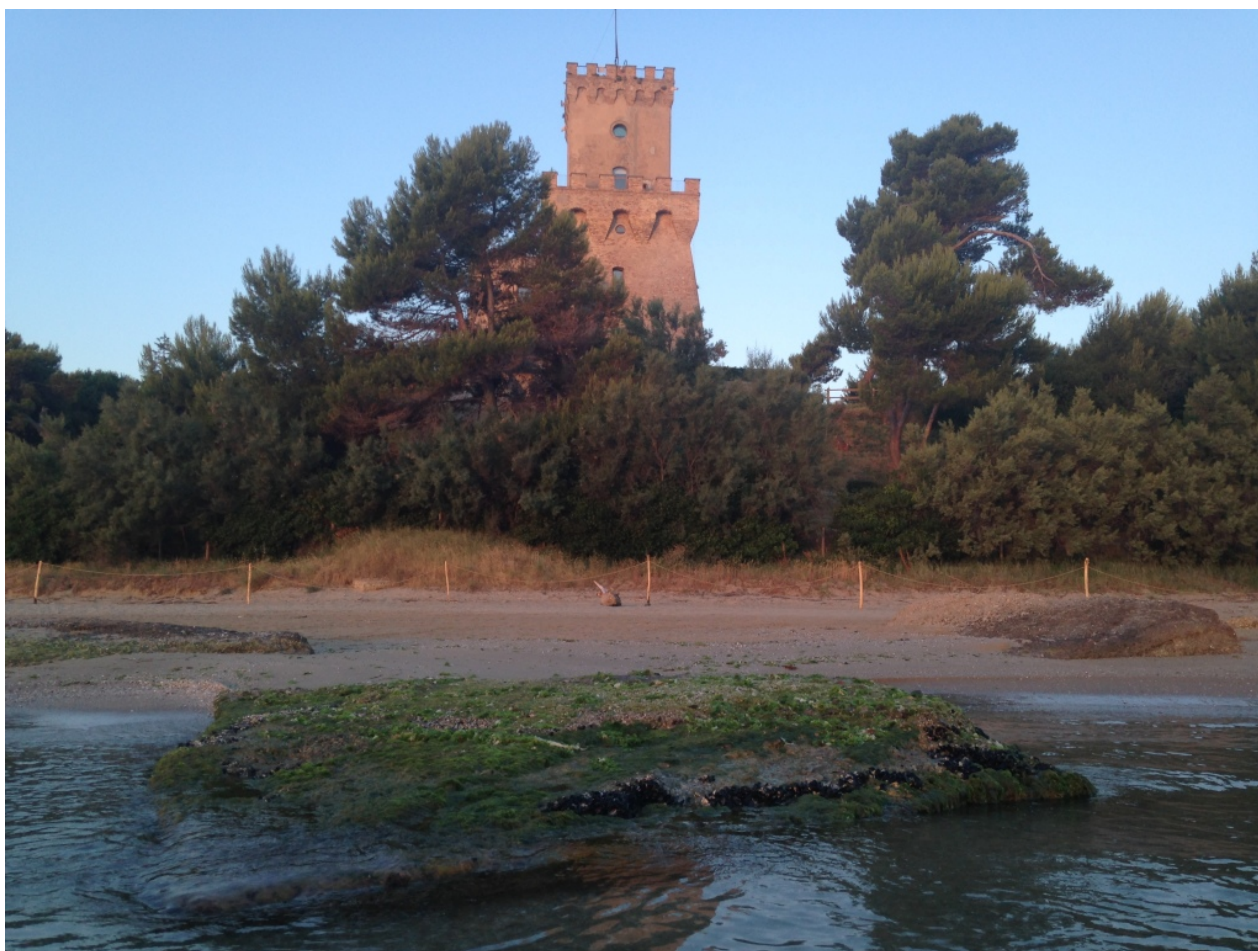
Torre del Cerrano
