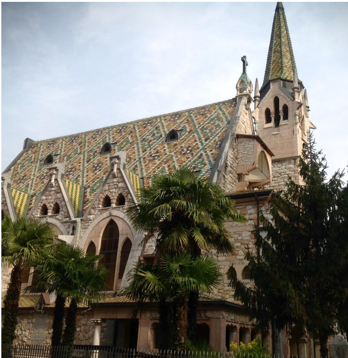
Chiesa Evangelica della Trinità – Arco
