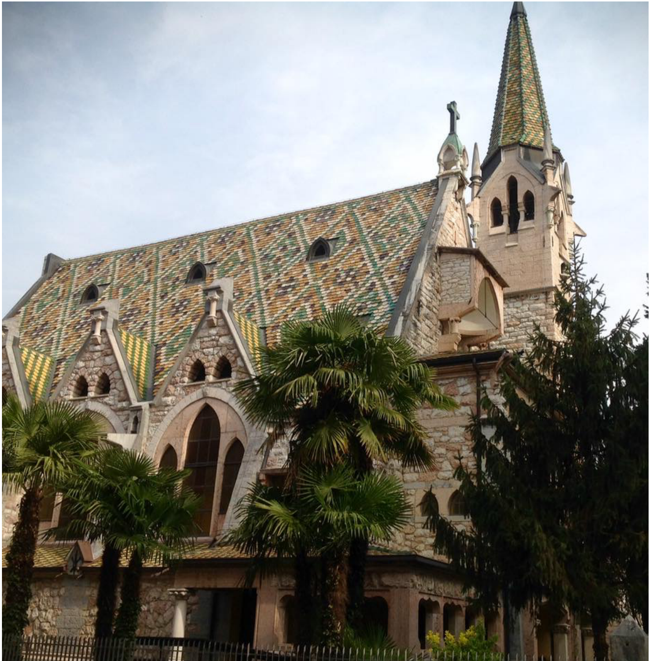
Chiesa Evangelica della Trinità – Arco
