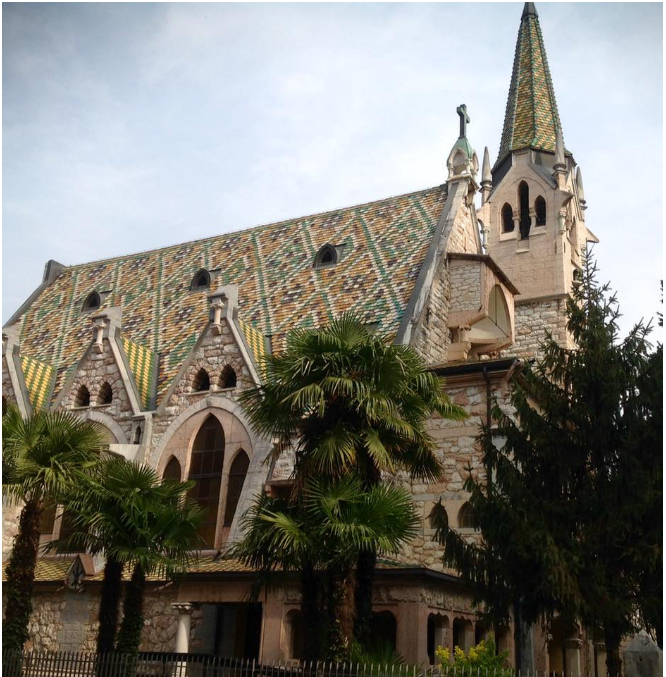
Chiesa Evangelica della Trinità – Arco
