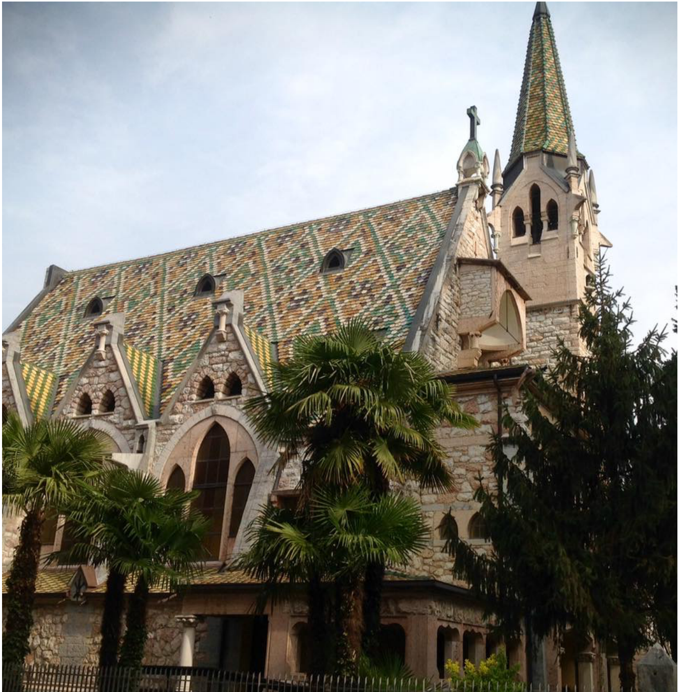
Chiesa Evangelica della Trinità – Arco
