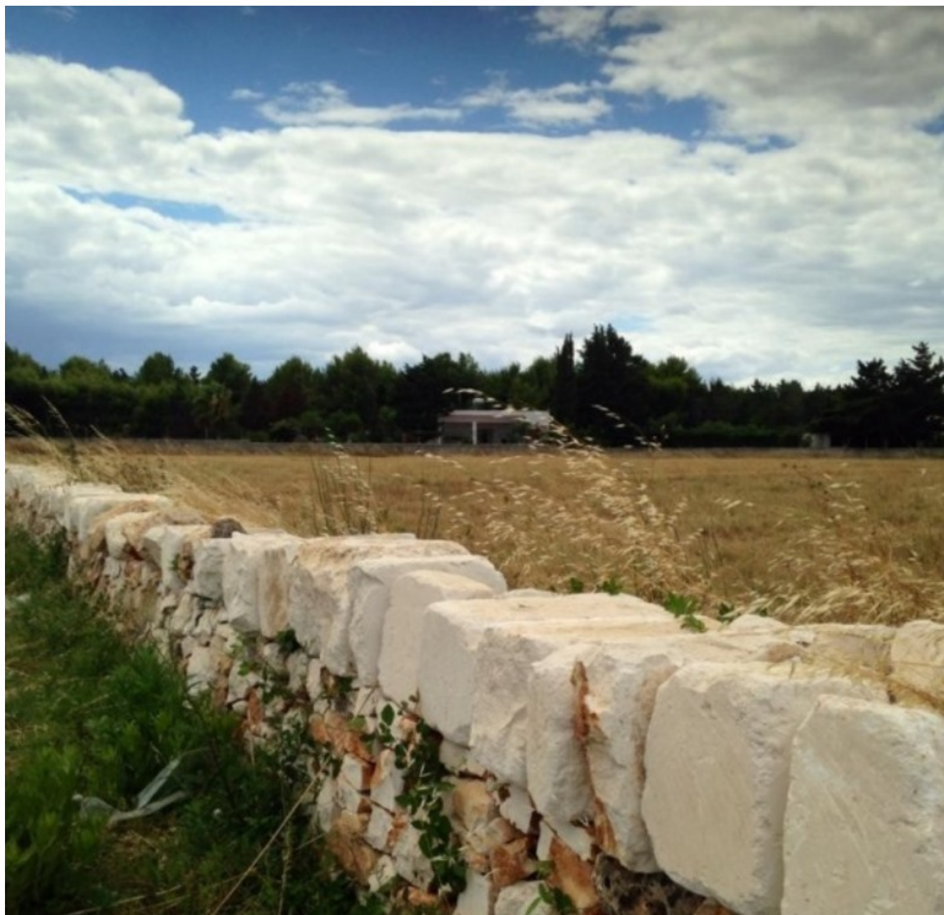
Muretti a secco
