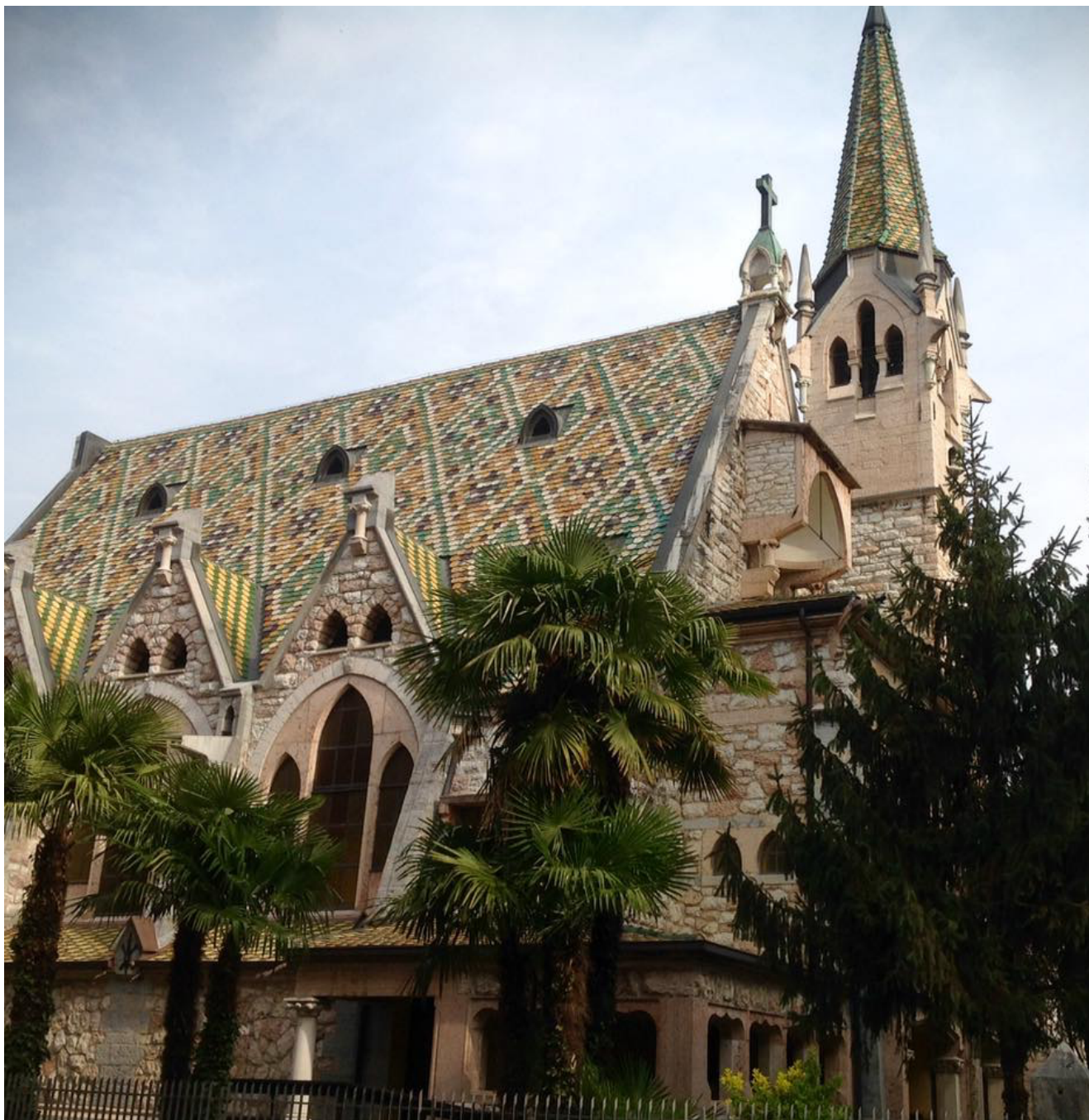
Chiesa Evangelica della Trinità – Arco
