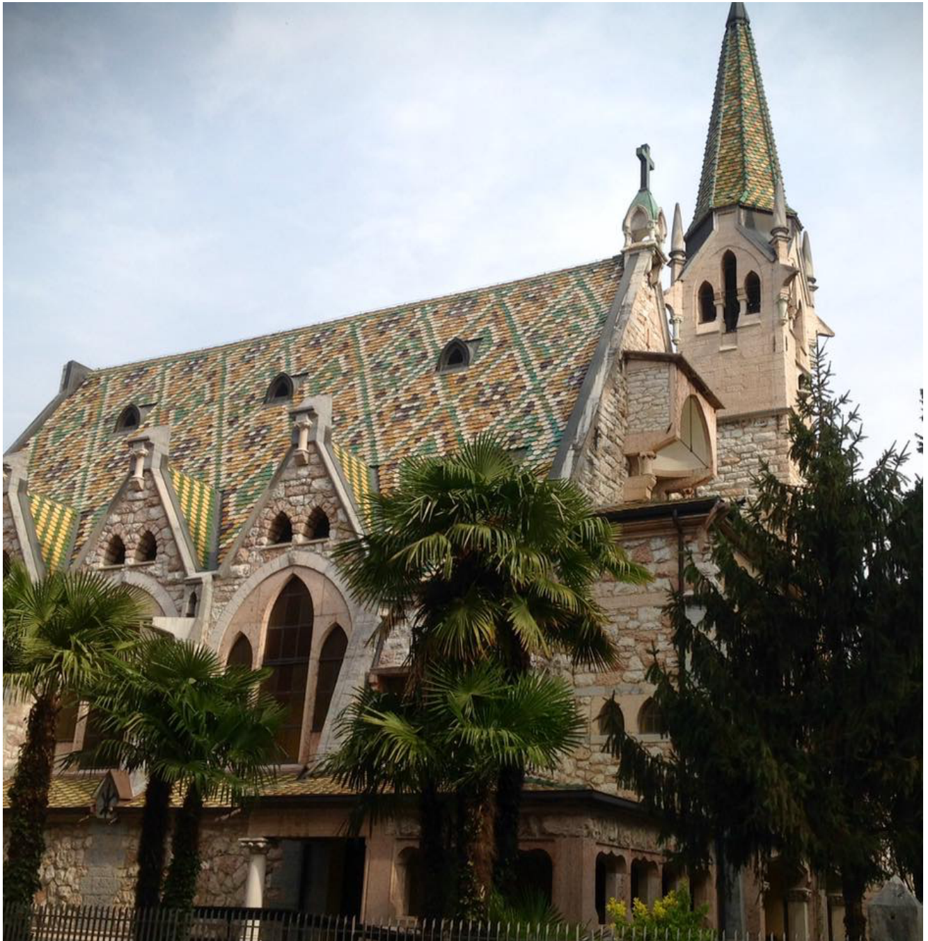
Chiesa Evangelica della Trinità – Arco
