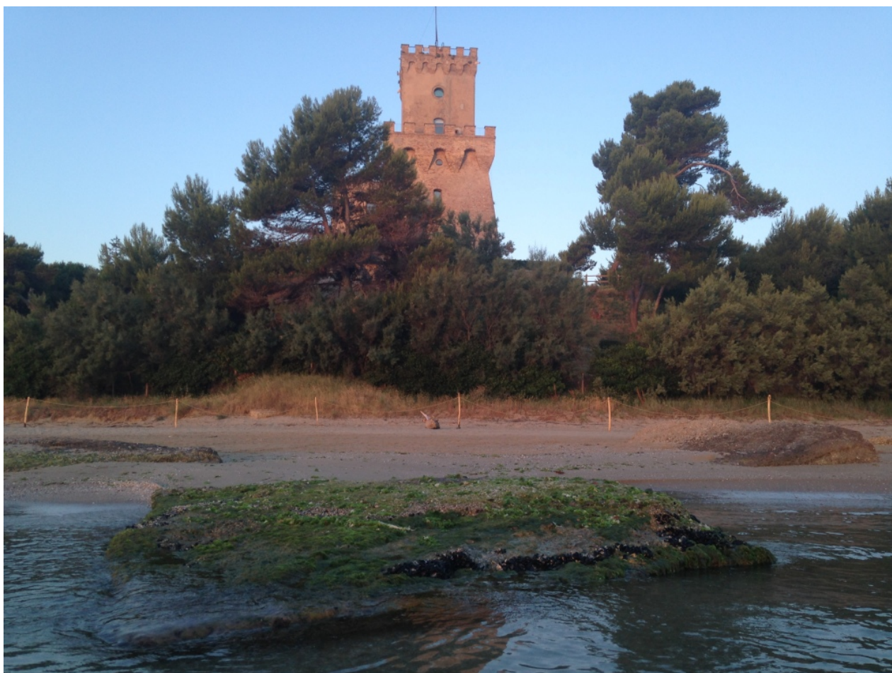
Torre del Cerrano
