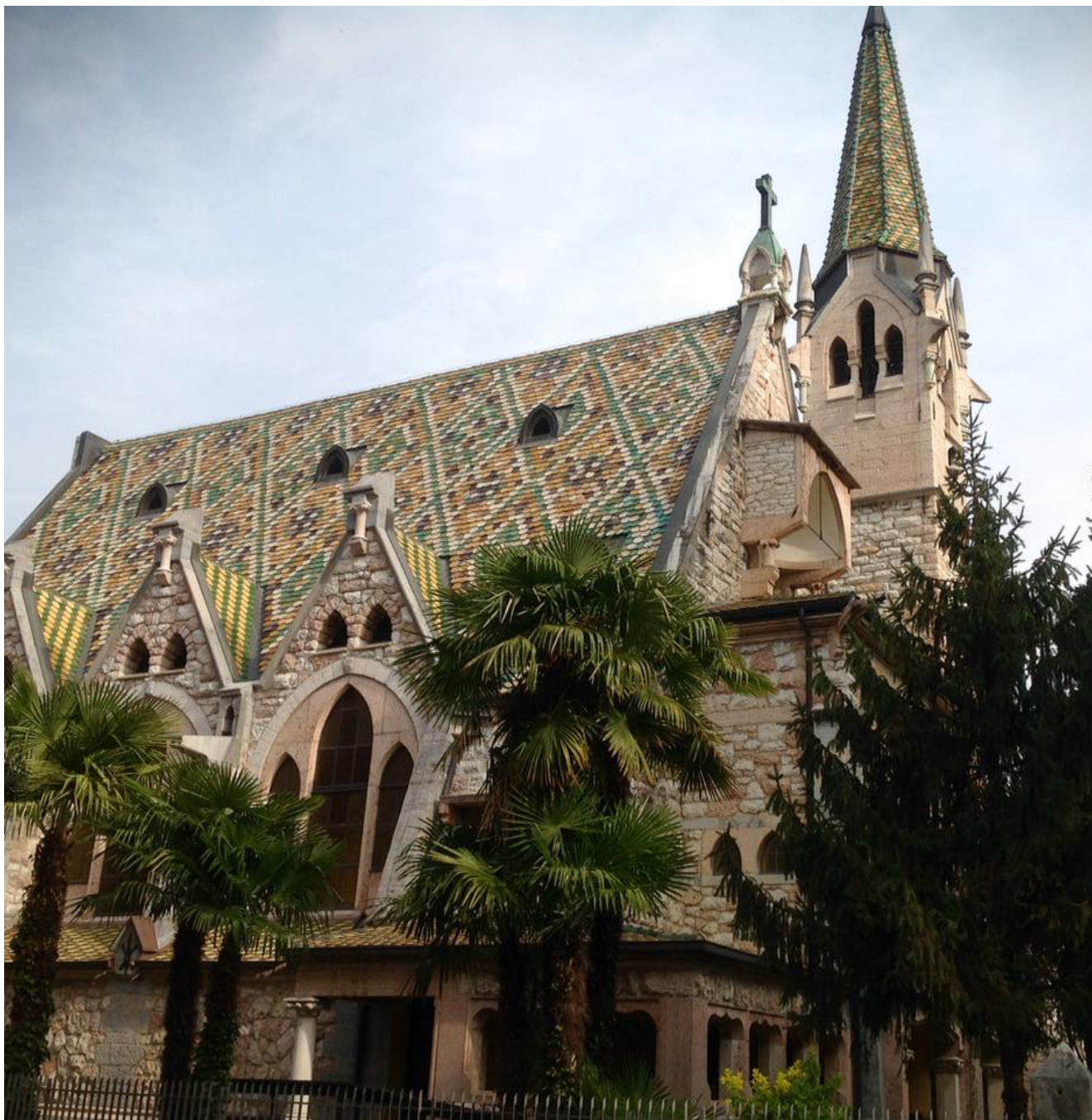
Chiesa Evangelica della Trinità – Arco
